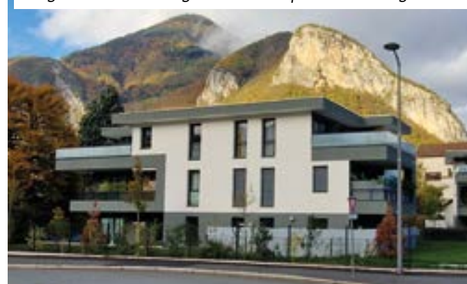
Les Lys du Privilège à Faverges, un exemple de mixité sociale avec 9 logements sociaux intégrés dans cette opération de 27 logements.
