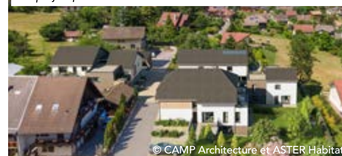
La Grange, 10 logements en cours de construction à Lathuile. Un projet qui mobilise le Bail Réel Solidaire dit BRS*.
