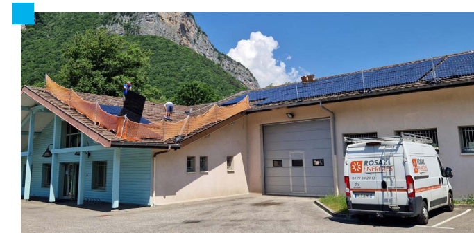
Pose des panneaux solaires sur la toiture du pôle technique en mai 2026
