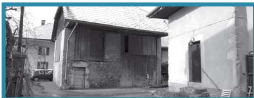
Batiment agricole de Villard-sur-Faverges
