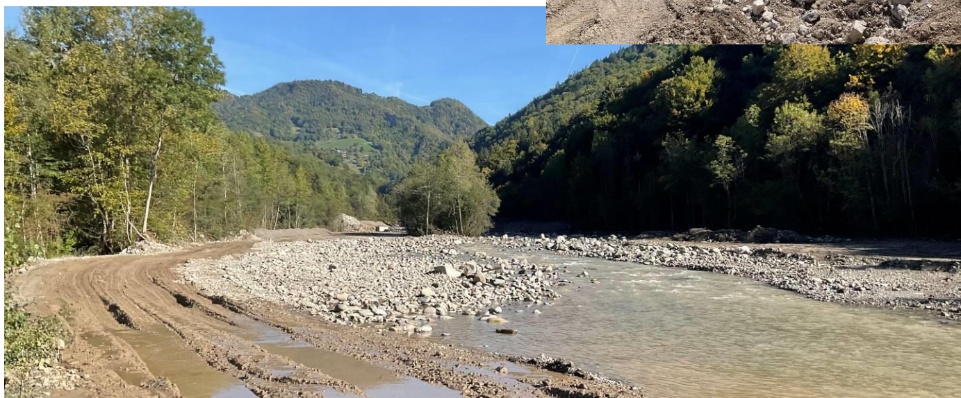
Travaux de terrassement en cours (octobre 2022)
