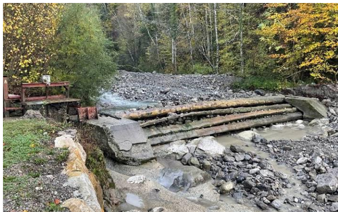
Le seuil avant travaux
